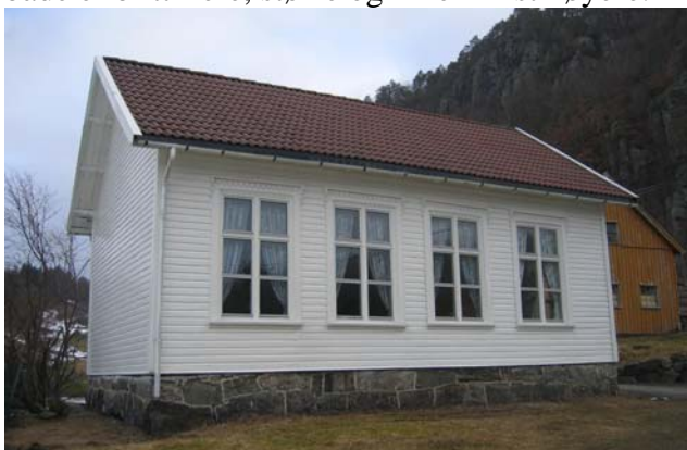
Foto 22, Stordrange skole oppført i 1898
