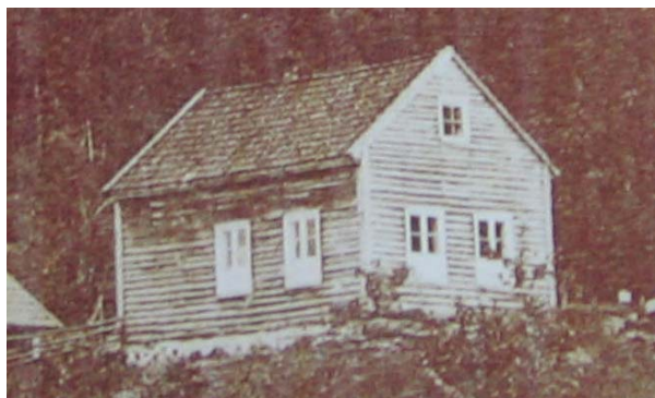
Foto 17, Suldalseid skole, oppført før 1879. Nye kvadratiske vinduer som er mindre en de opprinnelige er satt inn senere.
