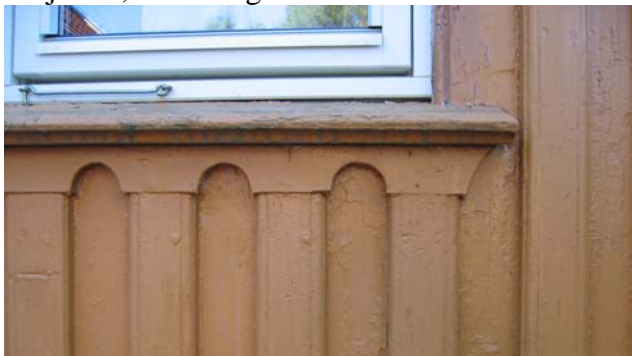
Foto 24, Dekor under vindu på Moy skole i Grimstad, oppført i 1864
