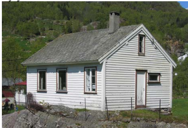
Foto 16, Hamrabø skule , oppført 1877-79. Vinduet til høyre på langveggen er innsett senere.
