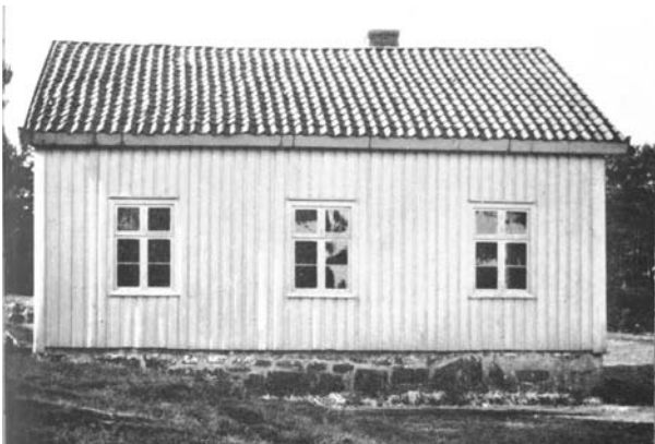
Foto 10, Jortviti skole bygget 1863
