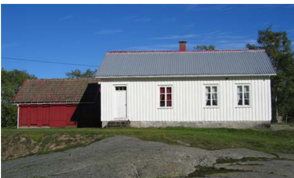
Foto 12, Hørte skole bygget 1884, med senere tilbygg
