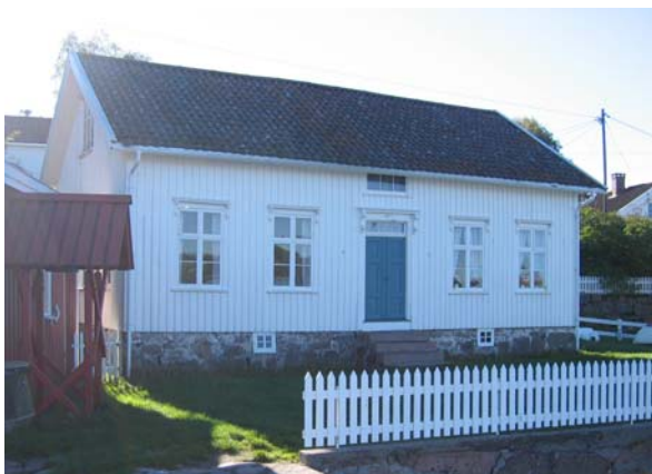
Foto 14, Hesnesøy skole bygget 1875-1900.
