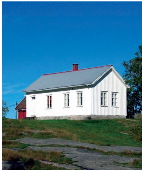
Fig. 1. Hørte skole i Grimstad, 1884. Nå i bruk som forsamlingshus. Alle foto ved artikkelforfatteren.
